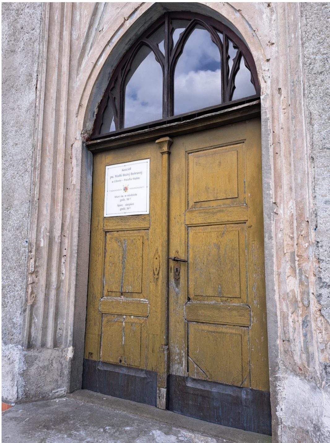
Wejście główne do kościoła – obecny stan zachowania
