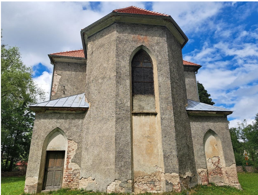
Elewacja frontowa (zachodnia) i wschodnia - stan zachowania w maju 2024 r.
