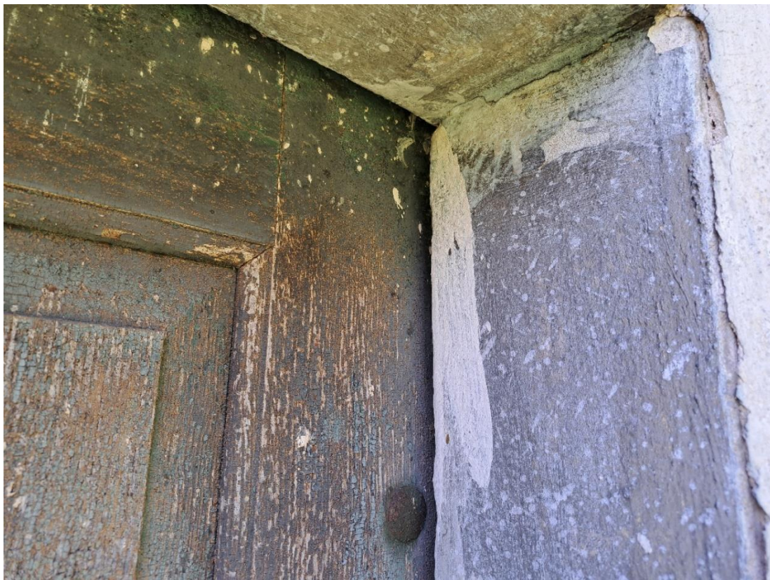
Wejście na elewacji wschodniej – obecny stan zachowania kamiennych ościeżnic, stolarki drzwiowej, oryginalna klamka
