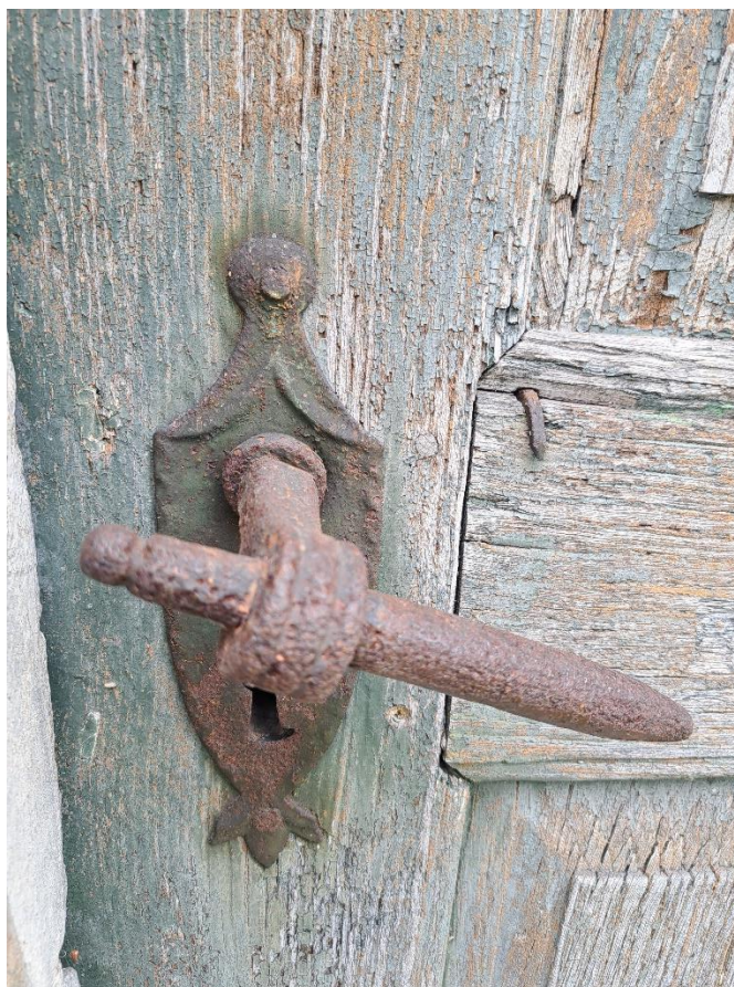
Wejście na elewacji wschodniej – obecny stan zachowania kamiennych ościeżnic, stolarki drzwiowej, oryginalna klamka
