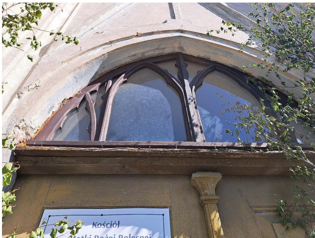
Elewacja zachodnia, frontowa oraz naświetle nad wejściem głównym – obecny stan zachowania
