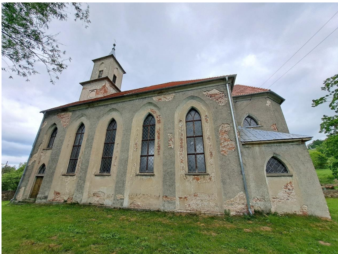
Elewacja północna i południowa -- stan zachowania w maju 2024 r.
