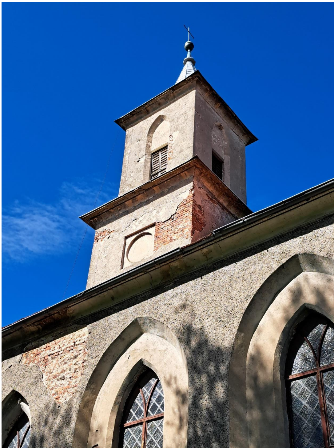
Widok wieży od strony północnej – obecny stan zachowania
