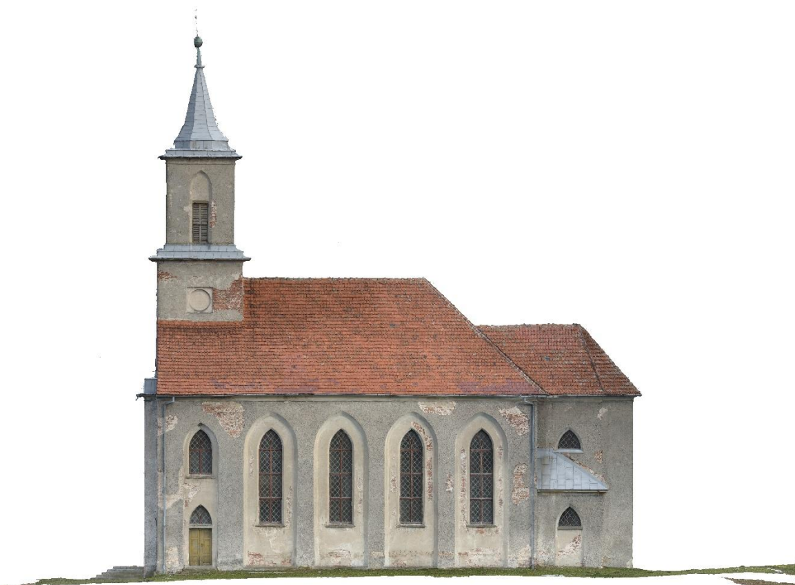
Fotoskan elewacji zachodniej kościoła z listopada 2021 r.
